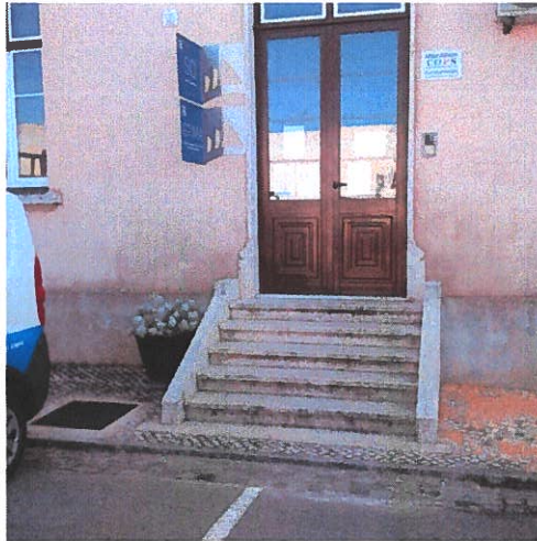
Acesso atual aos serviços do GRIMA e SSO
