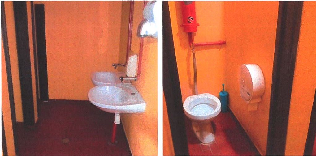
Instalações Sanitárias existentes
