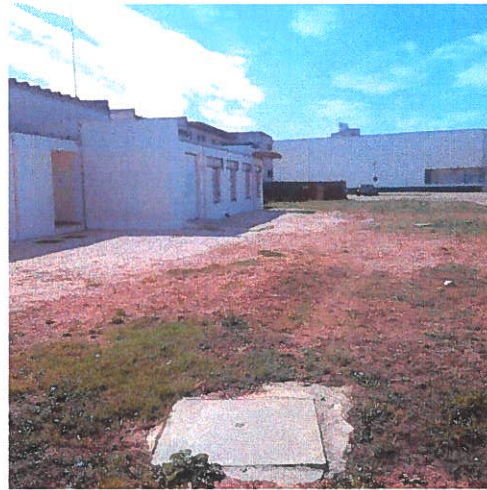
Zona a pavimentar
