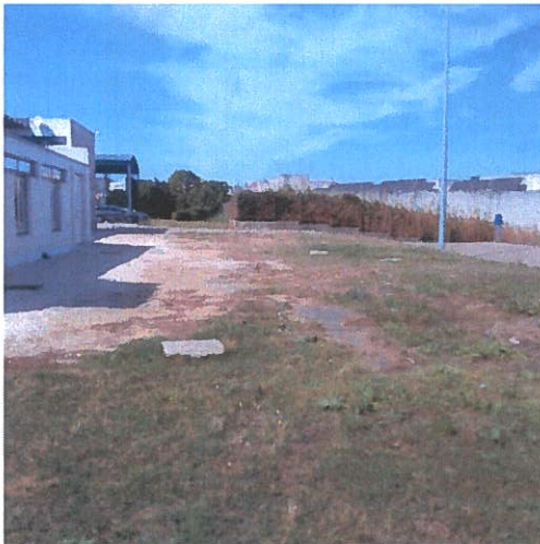
Zona de circulação a pavimentar
