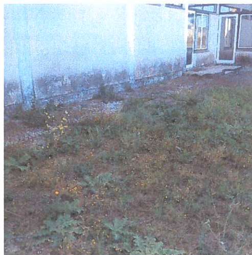
Zona de circulação a recuperar
