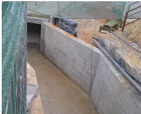
Figura 2.10 – Vista do canal de águas pluviais, do lado nascente da Praça dos Pescadores.
