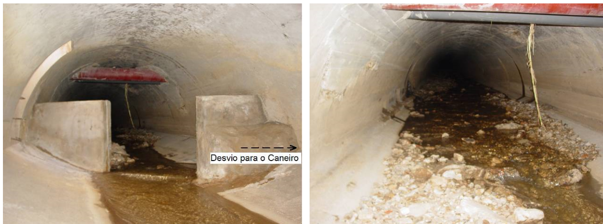
Figura 2.11 – Vistas do túnel para montante, incluindo parede descarregadora e desvio (à direita) para o caneiro.
