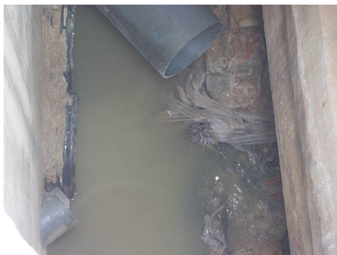
Figura 2.15 – Vista da Cx F618 e da parede descarregadora aí existente.
