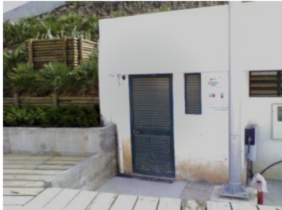
Figura 2.9 – Vista da Estação Elevatória dos Pescadores.
