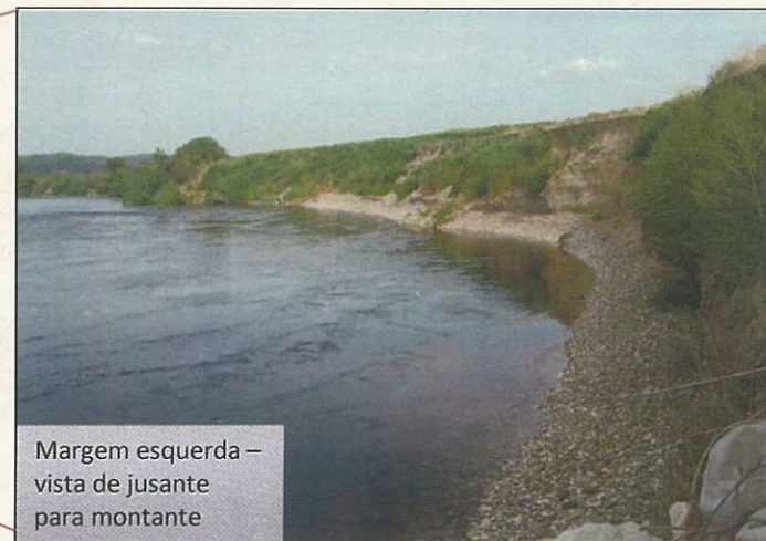
Margem direita – vista de montante para jusante
