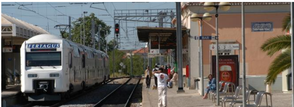
FIGURA 3 – A ATUAL ESTAÇÃO TERMINAL DE SETÚBAL
