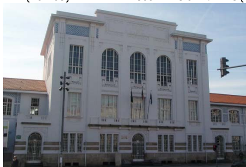
Escola Básica e Secundária Rodrigues de Freitas (Porto); Créditos das fotos: Google Maps.
