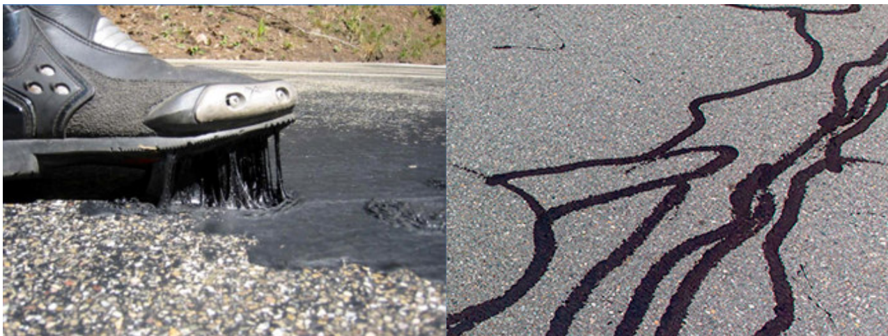
Figura 5 - Uso de materiais escorregadios para cobrir fissuras nos pavimentos coloca em perigo a vida dos motociclistas
