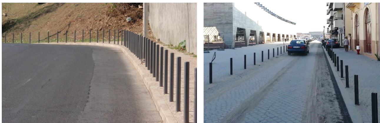
Figura 10: Perigo de balizadores verticais metálicos em reta e em plena curva.
