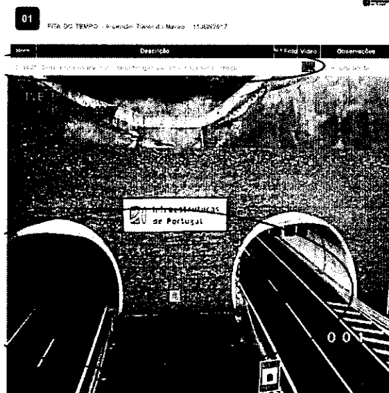
Imagem 21: Saída de fumo da galeria Sul – desenfumagem a funcionar no sentido do tráfego, enquanto, que na galeria norte funciona em sentido oposto.
