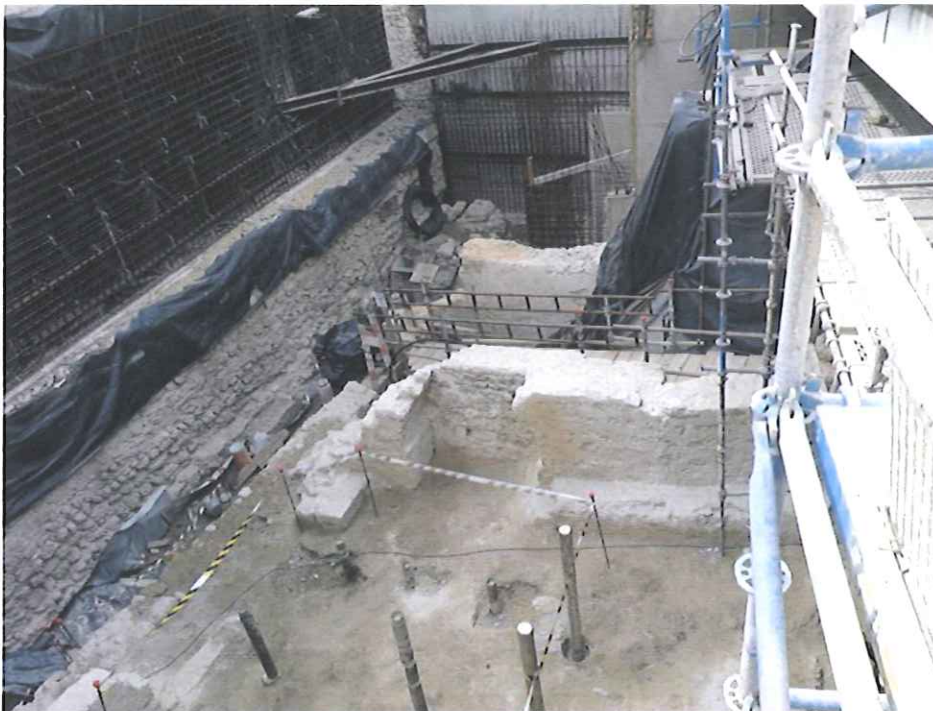
Nível intermédio das estruturas da Mesquita aljama de al-Ushbuna; compartimento interpretado preliminarmente como base do minarete; com arco.
