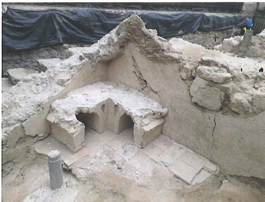
Nível intermédio das estruturas da Mesquita aljama de al-Ushbuna; compartimento interpretado preliminarmente como vestiário do hamam .
