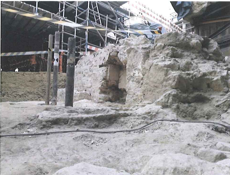
Nível intermédio das estruturas da Mesquita aljama de al-Ushbuna; compartimento interpretado preliminarmente como base do minarete; nicho embutido e estucado.
