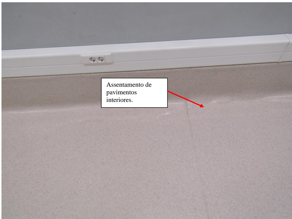
**FOTO 6 – ZONA DE ASSENTAMENTO DO PAVIMENTO NO INTERIOR**
