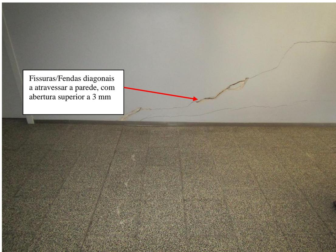
Fissuras/Fendas diagonais a atravessar a parede, com abertura superior a 3 mm
