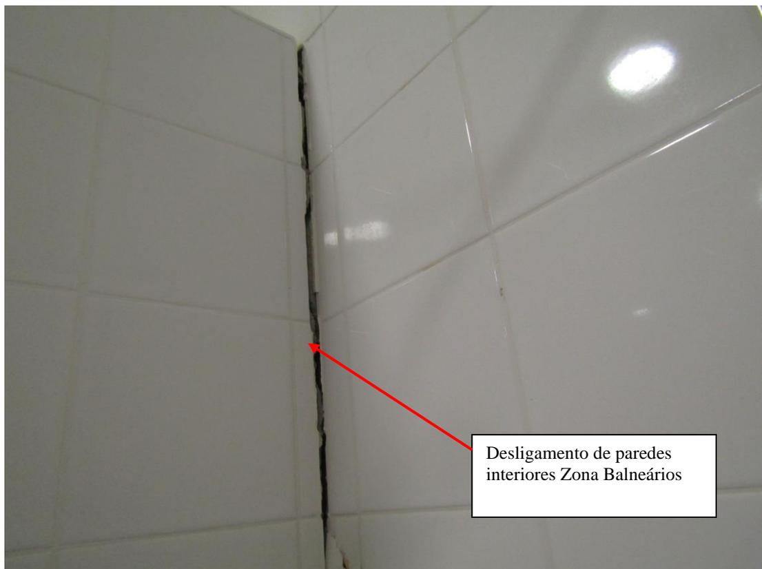
**FOTO 12 – DESLIGAMENTO DE PAREDES DIVISÓRIAS DE BASES DE DUCHE**
