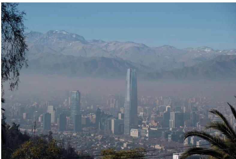
Figura 1 - Santiago de Chile - vista de teleférico. A cidade conta cerca de 8 milhões de habitantes e estende-se, desordenadamente, ao longo do vale onde se encontra estabelecida.
