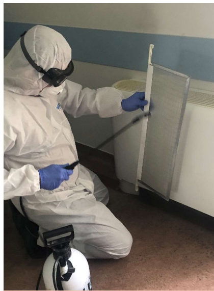
Desinfecção de filtros de VCs
