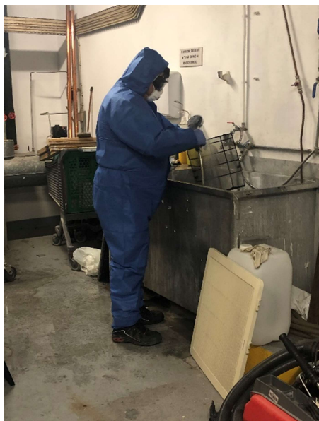
Lavagem de desinfecção de Filtros
