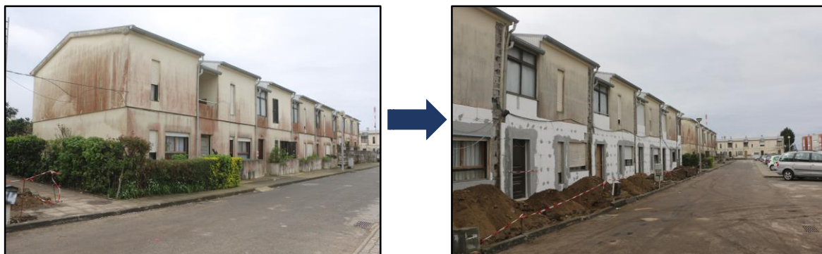
Matosinhos – Obra em curso no Conjunto Habitacional da Guarda
