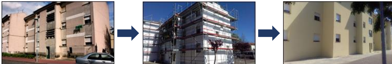
Arcozelo (Barcelos): obra concluída
