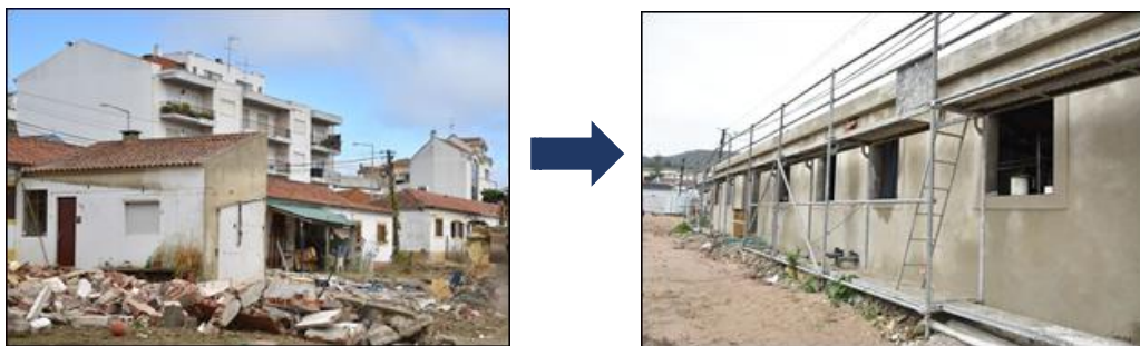
Arruda dos Vinhos – Obra em curso no bairro João de Deus
