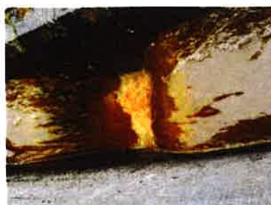
Figura 2: Coloração visível no efluente da decantação primária.
