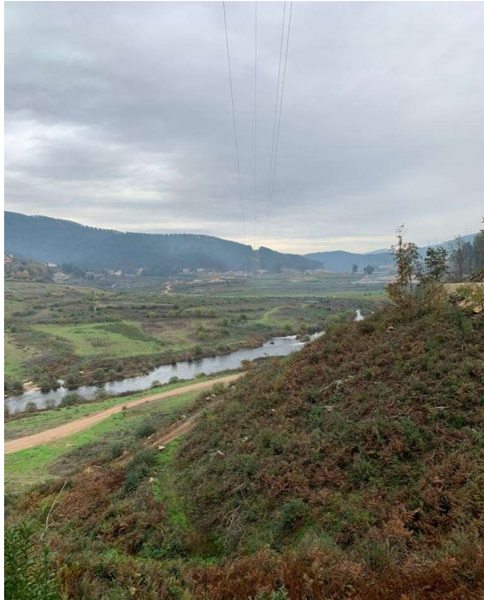
Linha Construída pelo, EHATB - Empreendimentos Hidroelétricos do Alto Tâmega e Barroso, EIM, SA
