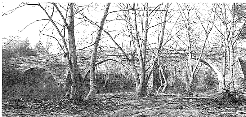
Fig. 2: Vista de montante da zona sul da ponte da Lagoncinha.
