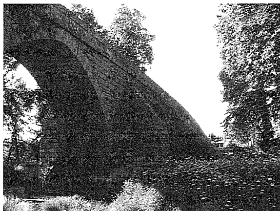
(d) Quebra - mar entre o arco 3 e o arco 4- Vista de montante - Lado Trofa
