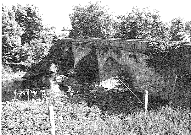
(a) Encontro, quebra - mares entre os arcos 1 e 2 e arcos 2 e 3 - Vista de montante - lado de Famalicão
