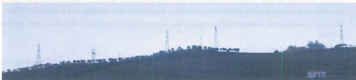
Foto 1 – Postes e Linhas de MAT, numa zona de cumeeada.
