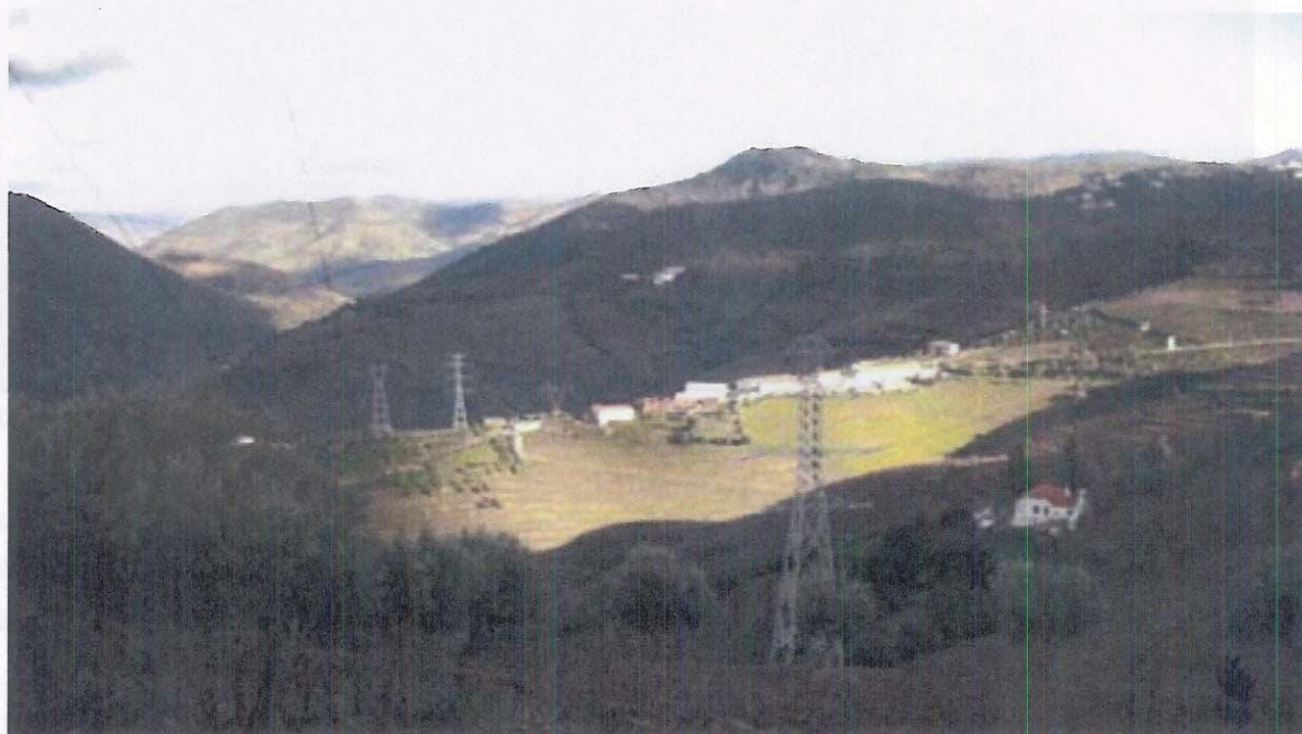
Foto 2 – Postes e Linhas de MAT, em zona de encosta.
