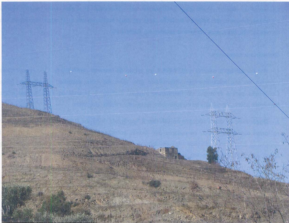
Foto 3 – Postes e Linha de MAT com bolas, face a uma construção vernacular.
