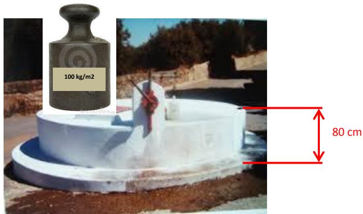
Figura 22 – Poço com cobertura e resguardo eficaz
