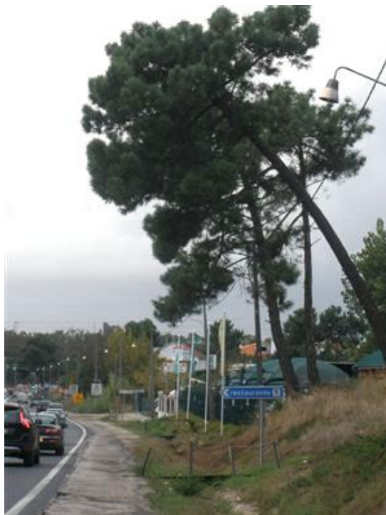
Figura 23 – Árvore em risco de queda para a via pública
