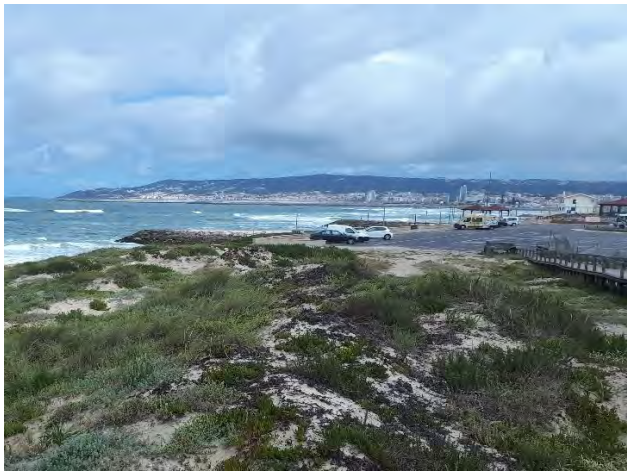
10.7 Vista para norte a partir do enraizamento do esporão nº 5. Esporões nº 4 e nº 3 e parque de estacionamento na frente urbana. Início de um passadiço em madeira de acesso à praia.
