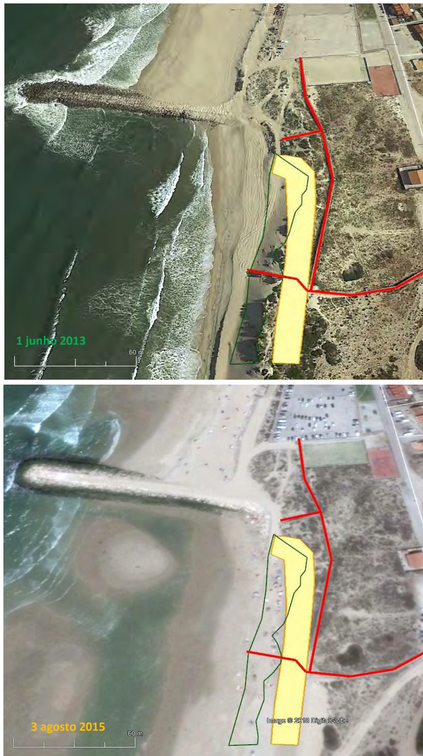
Figura 2. Recuo acentuado do talude erosivo da duna entre junho de 2013 (cor verde) e agosto de 2015 (amarelo). A cor encarnada, estão assinalados os passadiços de madeira de acesso à praia. Na imagem de agosto de 2015 são evidentes, a sul do tronco do esporão, bancos de areia submersos ou parcialmente submersos.
