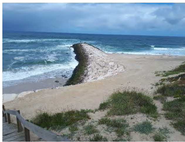
10.2 Vista para poente do enraizamento e do esporão nº 5, evidenciando a diferença em termos de acumulação sedimentar entre as praias a norte (barlamar) e sul (sotamar).
