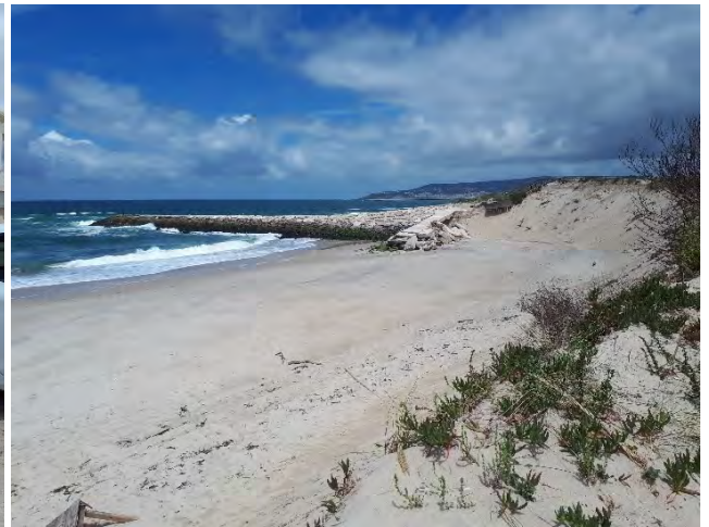
10.12 Vista para norte da zona a intervirer mais próxima do enraizamento do esporão nº 5.
