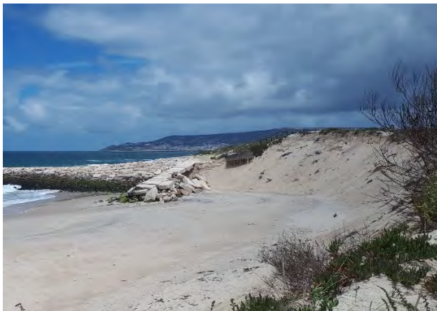
10.13 Pequena estrutura em enrocamento a sul do enraizamento do esporão nº 5 que era aderente e que presentemente está destacada e parcialmente destruída (a reposicionar).
