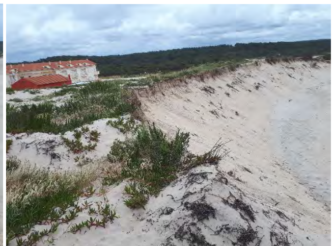
10.10 Vista para sul. Acentuado talude de erosão na formação dunar. Edifícios de habitação em risco.
