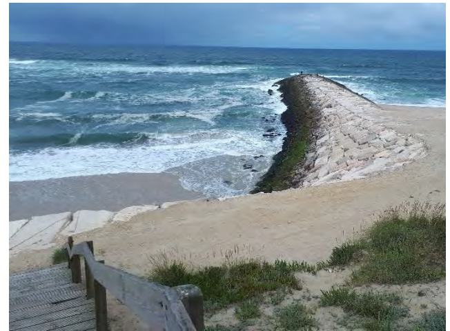
10.8 Extremidade destruída de um passadiço em madeira que existe próximo do alinhamento do esporão.
