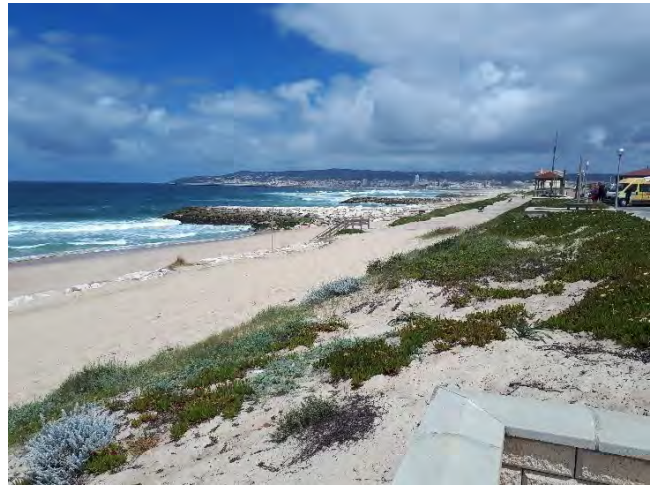
10.6 Vista para norte a partir do enraizamento do esporão nº 5. Esporões nº 4 e nº 3 e parque de estacionamento.
