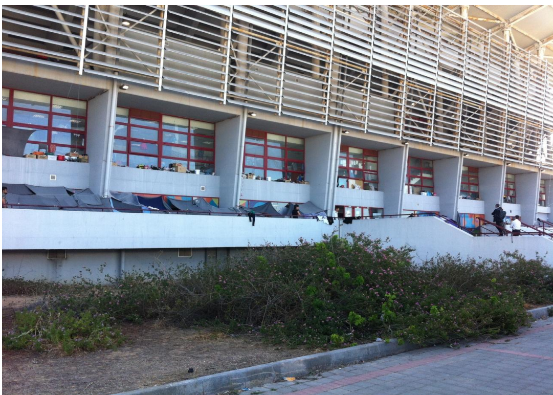
Foto 7: Imagem do edifício observado na fotografia anterior, correspondente ao edifício principal da antiga aerogare.
