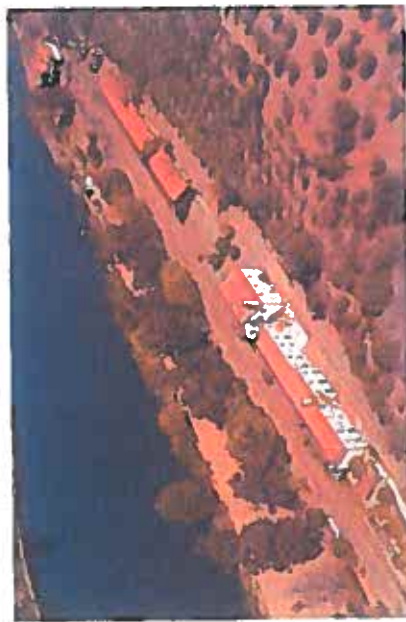
Figura n.º 31 – Estação de Barca D'Alva (km 199,6)
