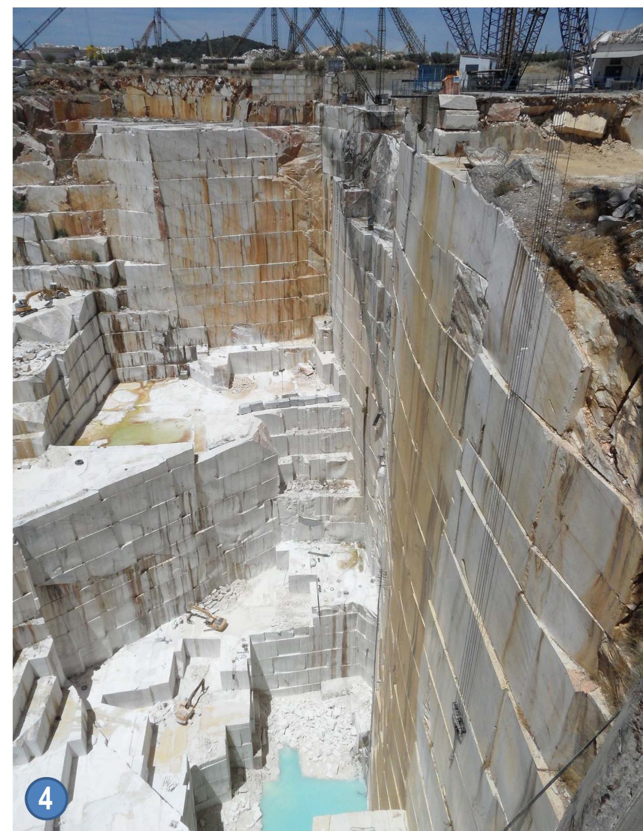
Figura 5: Panorâmica da pedra mais profunda em atividade no anticlinal de Estremoz (150 m). Regularmente estes taludes verticais são inspecionados para se detetarem eventuais planos de rotura e, se necessário proceder à sua estabilização.
