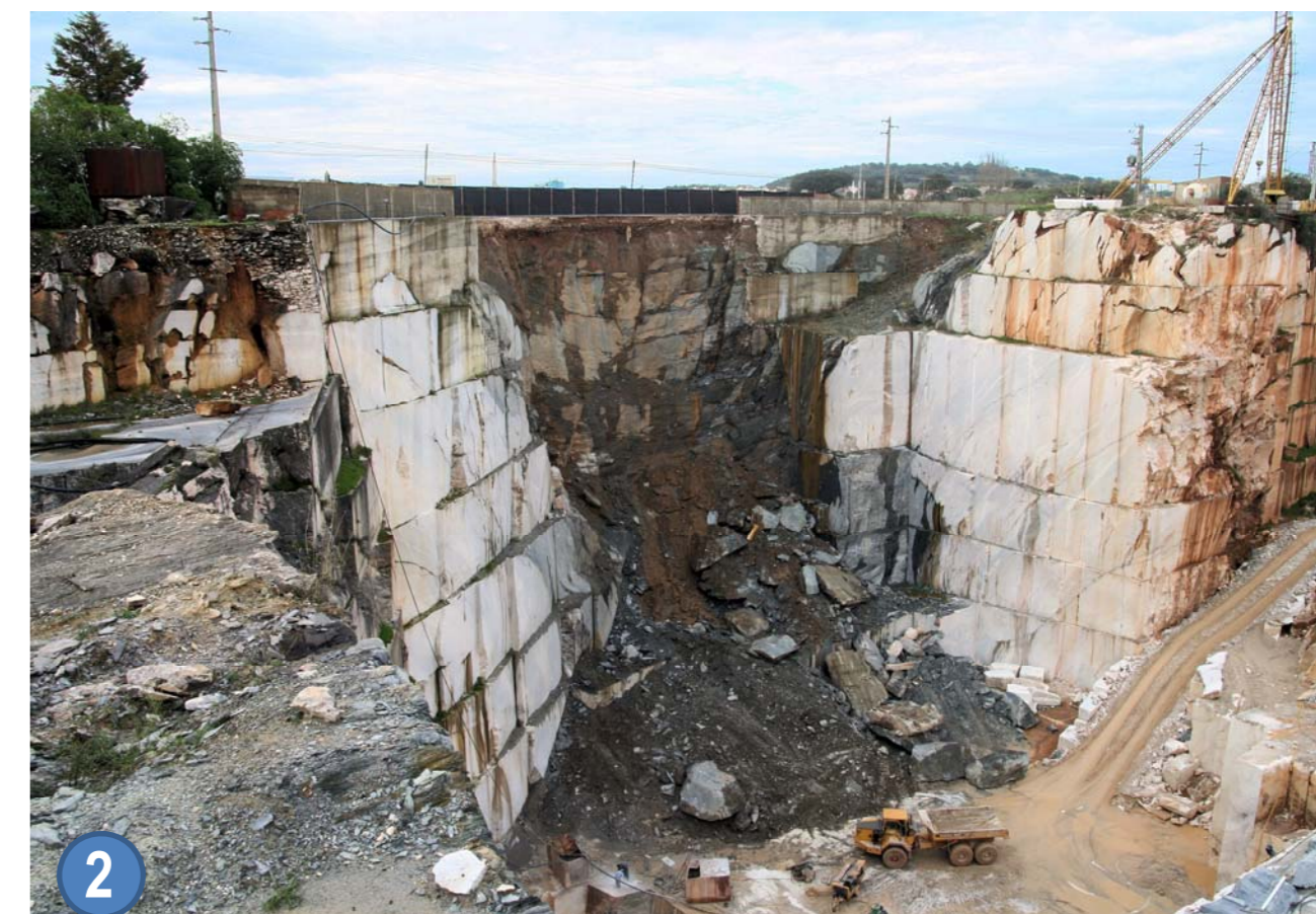
Figura 3: Deslizamento planar ao longo do plano de xistosidade no contato entre os metavulcanitos básicos do CVSCE e os mármore. Como consequência deste desastre a estrada camarária de acesso às pedreiras da zona da Vigária colapsou mas não houve vítimas a lamentar.
