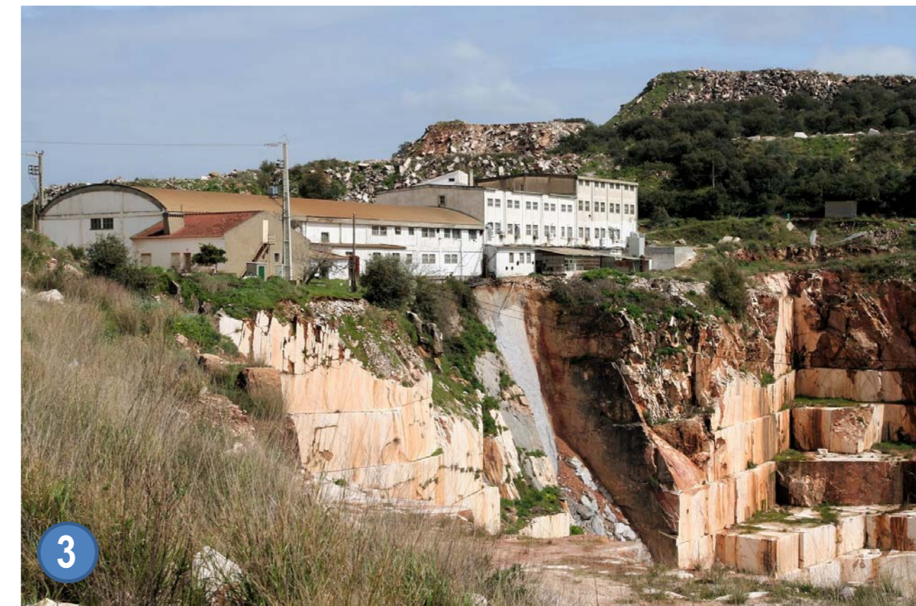
Figura 4: Deslizamento planar ao longo do plano de xistosidade no contato entre os metavulcanitos básicos do CVSCE e os mármore e limitado a sul por um filão dolerítico ENE-WSW, 90. Embora sem consequências para as estruturas a NE (direita) este acidente evidencia o risco a que as mesmas estão sujeitas.
