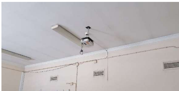
Fotografia do teto do piso 0, com vigotas pré-fabricadas visíveis na laje
