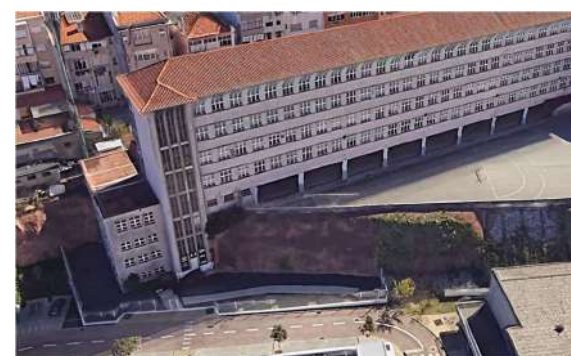
Imagem aérea do talude no limite da escola
