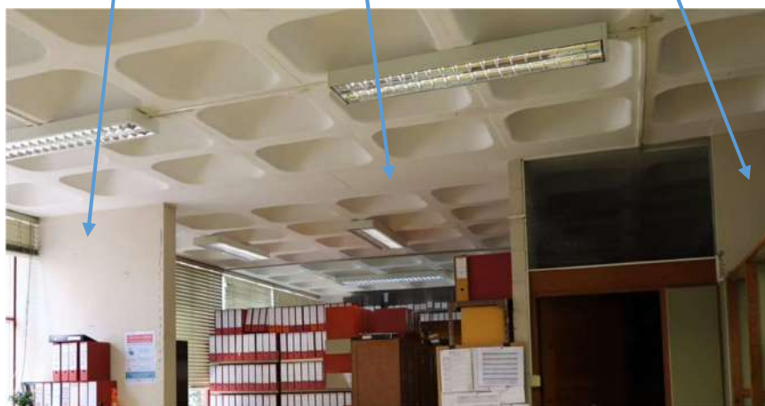
Lajes fungiformes com zonas maciças nos alinhamentos entre paredes
