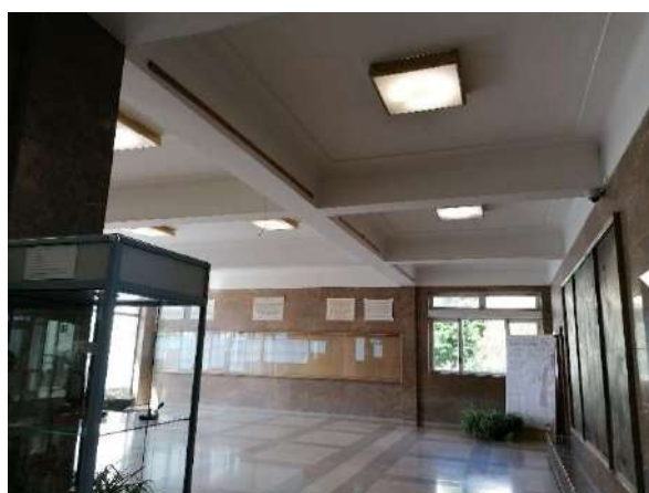
Corpo A do edifício principal – zona ampla da entrada com vigas e pilar central
