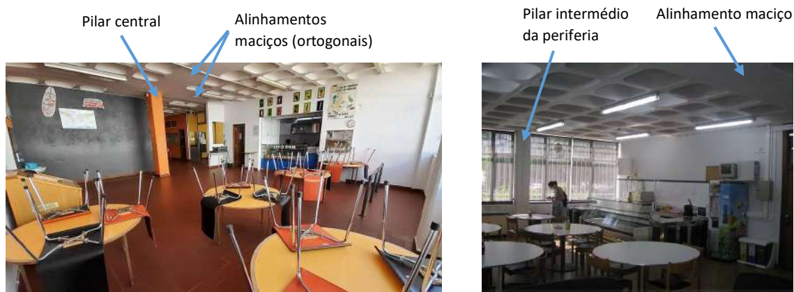
Lajes fungiformes com zonas maciças nos alinhamentos centrais: bloco do refeitório (esq.); bloco A (dir.)
