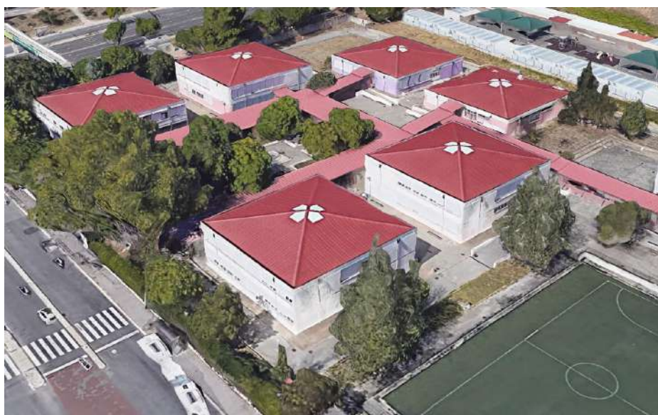
Figura 3.4 – Escola secundária do Restelo (tipologia pavilhonar 3x3)
