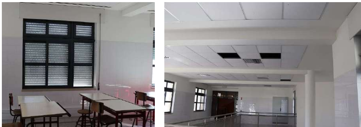
Fotografias da visita à escola: sala de aula com viga aparente (esq.); zona de entrada do bloco CC, com pilares circulares e vigas aparentes (dir.)
