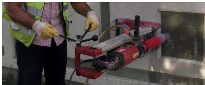
Figura 6.7 – Extração de provete de betão para ensaio laboratorial
