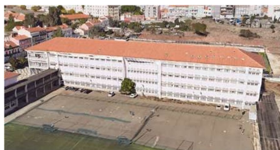
Imagem aérea do edifício principal
