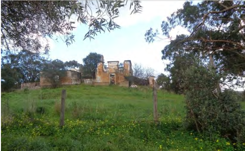
Figura 19 – Estado de abandono do edificado existente
