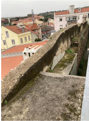
Estado de Conservação da Muralha Sudoeste: Adulteração dos materiais de revestimento. Apresenta desgaste do tempo, com fissuras. Novas construções sobre a muralha. Execução de aberturas/ acessos no pano da muralha. Ocorrência de infiltrações de águas residuais pluviais e de águas residuais domésticas com risco para a saúde pública.
