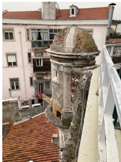
Guarita – Vista a partir do lado da Muralha Sudoeste/Travessa do Livramento. Estado de Conservação da Guarita: Guarita em avançado estado de degradação, amarrada com cintas, com ocorrência de desprendimento de material sobre os telhados das casas. Risco de ruína provocando danos nas habitações e nos moradores;
