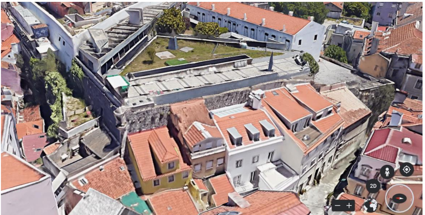
Figura n.º 2 – Muralha Sudoeste do Baluarte do Livramento (fachada orientada para a Travessa do Livramento. São visíveis só pequenos troços da muralha devido a construção de edifícios adóçados à muralha ocultando-a)
