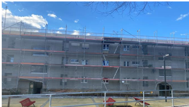
Ponte Lima 46 fogos em reabilitação
