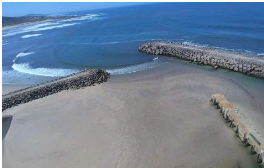
Figura 19 - Vila Praia de Âncora. Aspecto do assoreamento da bacia portuária do Porto de Pesca. Imagem em baixa-mar (foto Web sem data).
