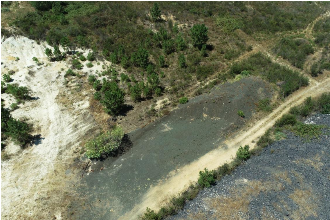
Figura 9 – Fotografia aérea do depósito de finos.
