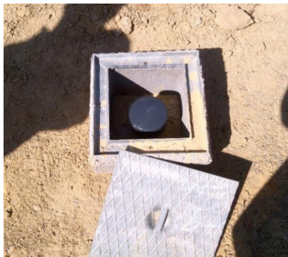
Figura 14 – Fotografia do piezômetro identificado junto ao limite NO do depósito de escórias.
