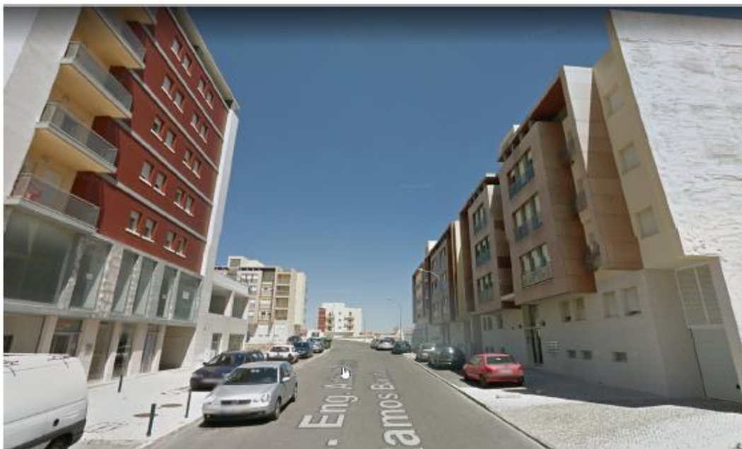
4 - Rua Engenheiro Adão Manuel Ramos Barata lote 31 – Camarate Ano de Construção: 2006-2011
