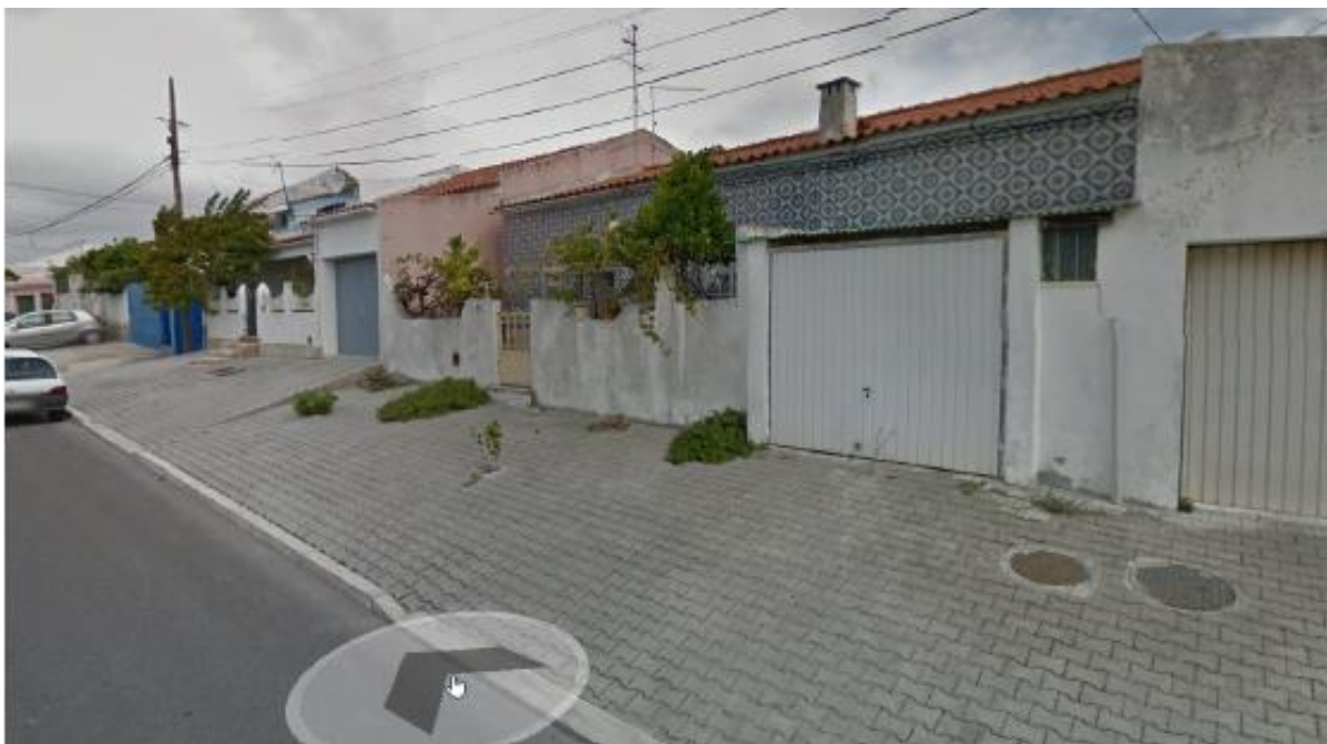
14 – Estrada Militar 7 – Unhos Ano de Construção: 1961:1970
