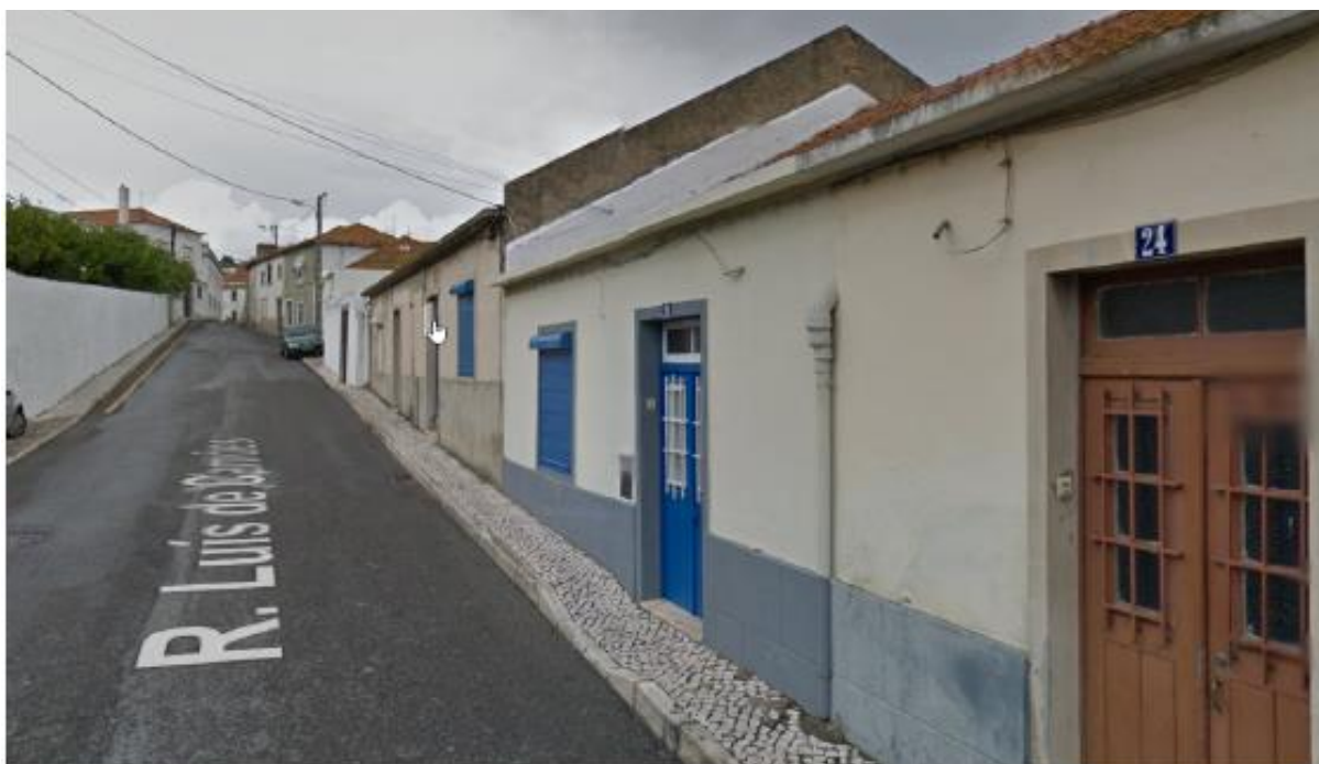
13 - Rua Luís de Camões nº 24 – Unhos Ano de Construção: 1961-1970
