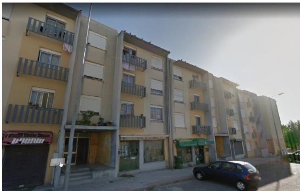
9 - Rua Agostinho Neto lote 63 – Sacavém Ano de Construção: 1996-2000
