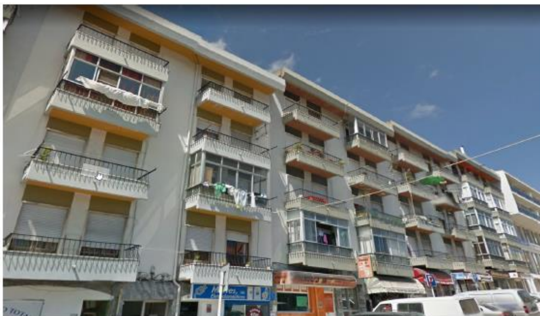
1 - Rua Guilherme Gomes Fernandes nº 12 – Camarate Ano de Construção: 1971-1980
