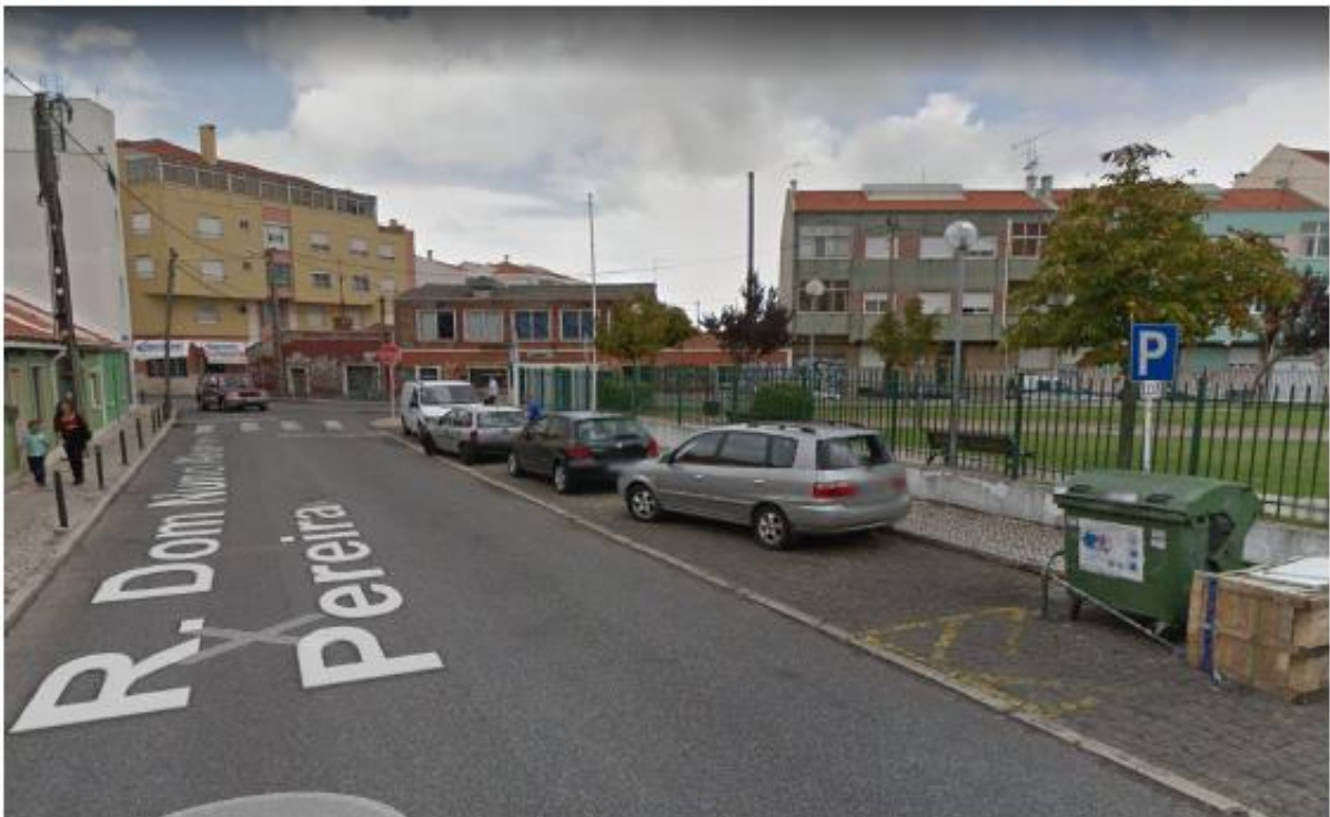
16 - Rua Dom Nuno alvares Pereira Zona Envolvente - São João da Talha Ano de Construção: 1946-1960
