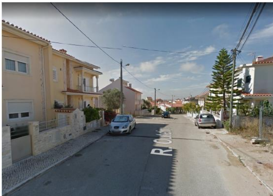
19 – Rua do Outeiro Zona Envolvente – Santa Iria de Azoia Ano de Construção 2001-2005
