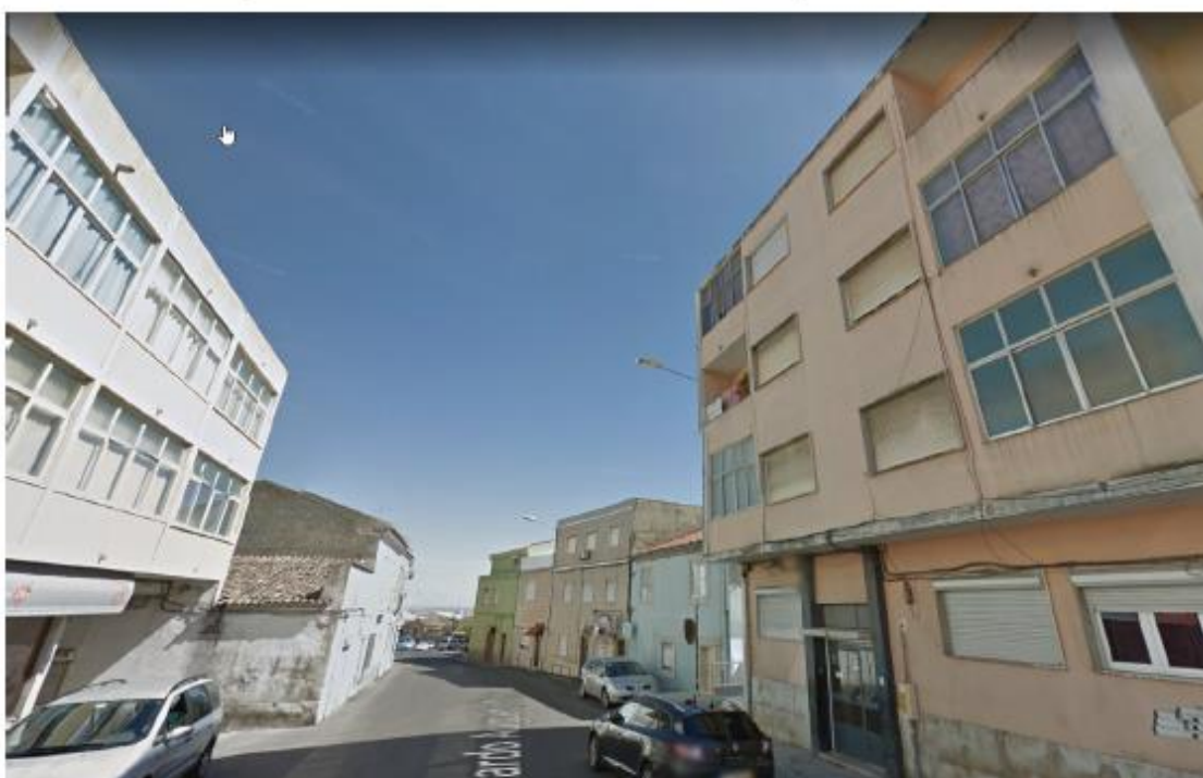
2- Rua Eduardo Augusto Pinto Zona Envolvente – Camarate Ano de Construção: 1946-1960
