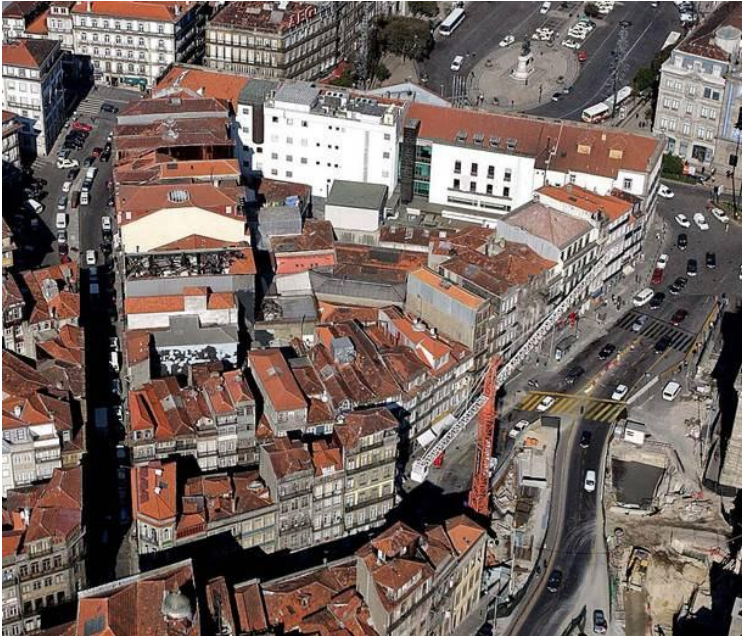
Fig. 7. Quartier des Cardosas avant les démolitions.
