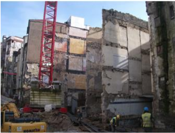
Fig. 13 - Aspect des actions de démolition à l'intérieur du quartier . Source: http://www.portovivosru.pt .
