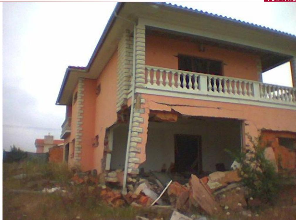
Acidente em moradia nova, resultado de explosão devido a fuga de gás por deficiência de execução da instalação de gás.
