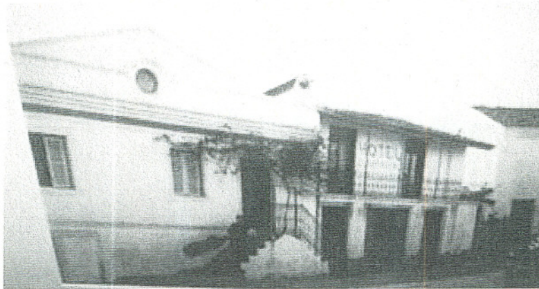
Foto1- Anterior traça do Edifício do Grã Hotel
