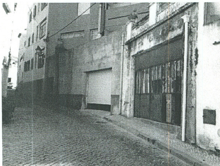
Foto 8 –Garagem vira Restaurante
