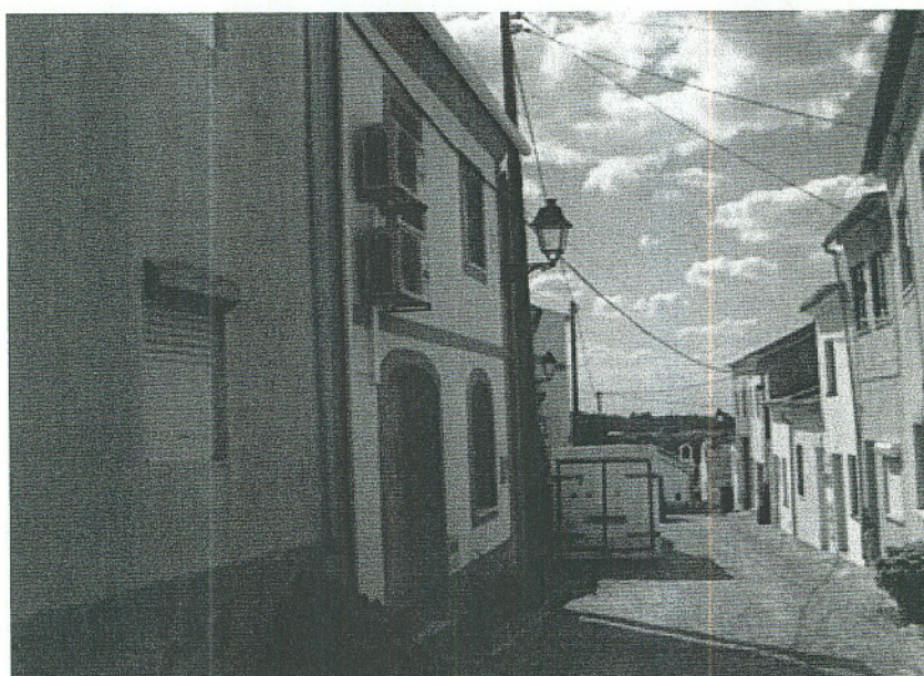
Foto 4 – Estilo arquitectónico desenquadrado e ar condicionado para rua
