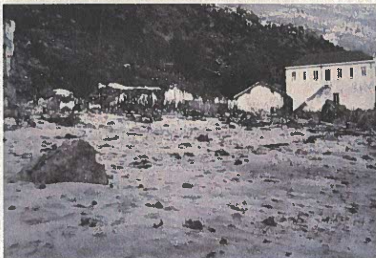
Figura 15 – instalações dos socorros a náufragos, em fundo, e aspecto da destruição do furacão de 40 nas construções existentes na praia (5) .
