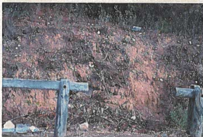
Figura 19 – Taludes gerados com a construção do parque de estacionamento.
