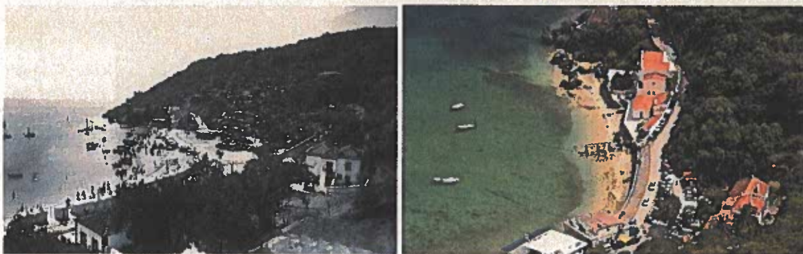
Figura 13 – Na imagem da esquerda, pormenor do parque de estacionamento original, ainda sobre o areal da praia. De notar que a utilização do espaço se fazia já de forma desadequada, tendo em conta a curvatura natural da baía (6). Na imagem da direita, observa-se a estabilização da linha de costa, ainda hoje existente, recorrendo a um paredão contínuo.
