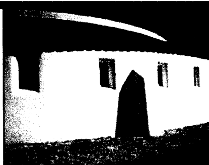
Arredondamentos racionalistas em frestas-janela e contrafortes, no exterior.
