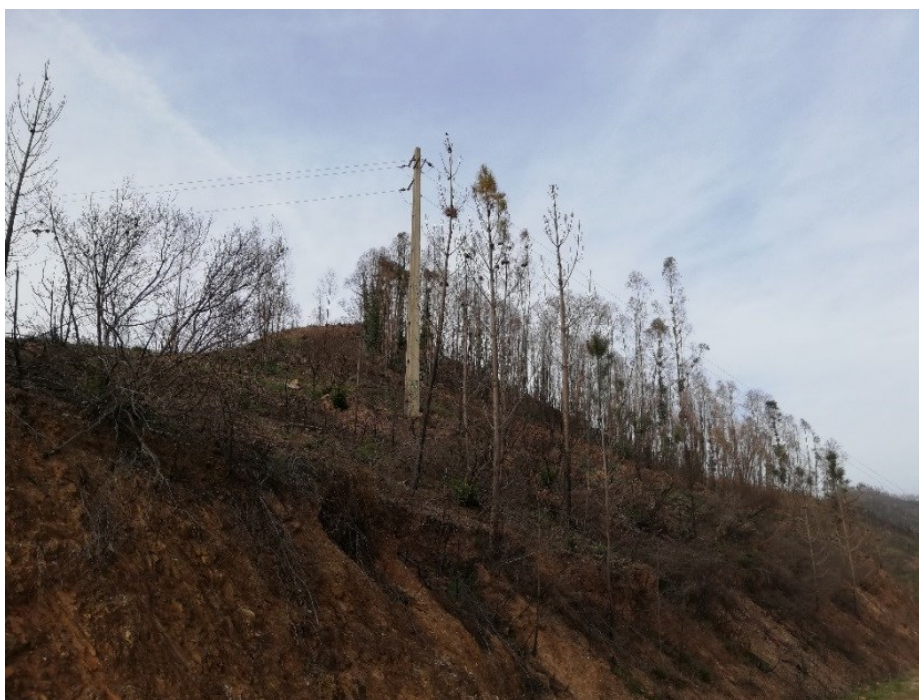
Figura 10. Local indicado como provável início do incêndio (Lat: 37.396944, Long: -8.588963; registo SGIF) debaixo de uma linha elétrica de média tensão (15kV), gerida pela EDP.
