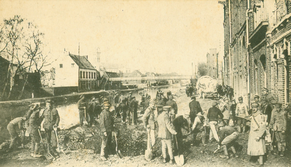
SECTOR PORTUGUEZ — Zôna devastada. Merville. — Reparando uma estrada.
