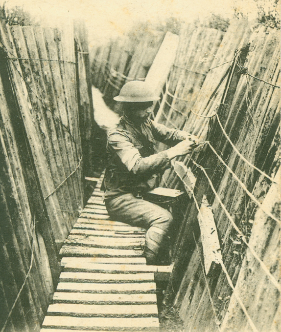
OS PORTUGUEZES NA FRENTE DE BATALHA Reparação dos fios telefonicos.
